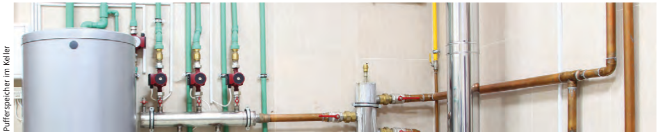
Pufferspeicher im Keller
