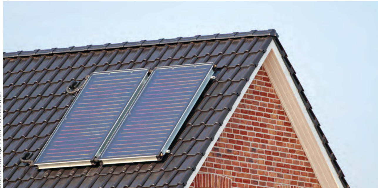
Solarthermieanlage mit zwei Flachkollektoren
